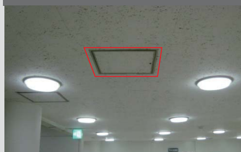
天井材の一部分のみ取り出し
